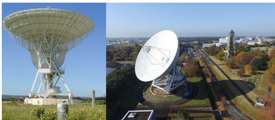
Slika 1-19: VLBI antena promjera 32 m, kolocirana s GNSS na EPN stanici Noto u Italiji, (EPN, 2017 b) lijevo. Desno je Tsukuba VLBI antena radijusa 32 metra, u Japanu. (GSI, 2017)
