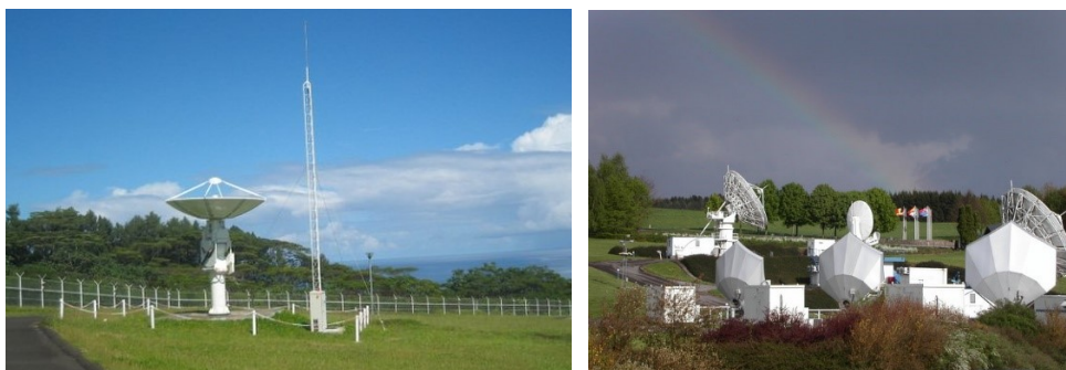
Slika 5.17: lijevo, ESA „uplink stanica“ Papette na Tahitiju, Francuska Polinezija. Zadatak ove stanice je da šalje podatke za sadržaj navigacijske poruke koje Galileo sateliti emitiraju korisnicima. (ESA, URL 5.543) Desno, antene na ESA kontrolnoj stanici Redu, lociranoj u Belgijskoj oblasti Ardennes. (izvor: ESA - D. Galardini, URL 5.44)
